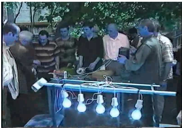
Рис. 1. 2007 г. Демонстрация работы электрогенератора
